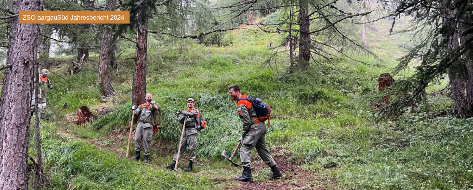
Pioniere bei den Aufräumarbeiten
